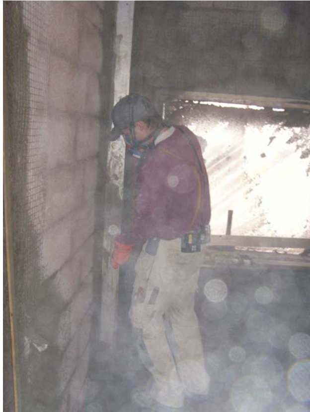
Figur 4. Fasttryckning av putsribbor
